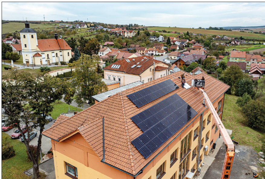
Pokládka solárních panelů na budově OÚ.
